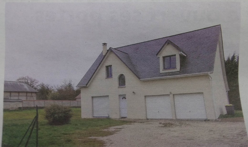
Derrière l'allure d'un pavillon type, se situe la nouvelle adresse du CMP et du CATTP.
